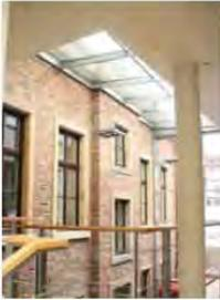
**Erweiterung ohne Substanzverlust am Kulturhaus Oberwesel:** Durch einen verglasten Zwischentrakt ist der alte Klinkerbau mit einem Neubauteil zusammengefügt worden. Trotz Erweiterung bleibt die **sehenswerte Fassade erhalten**. Die Außenwand wird zur Innenwand und es entsteht ein Raum mit besonderem Charakter und hoher Qualität.
