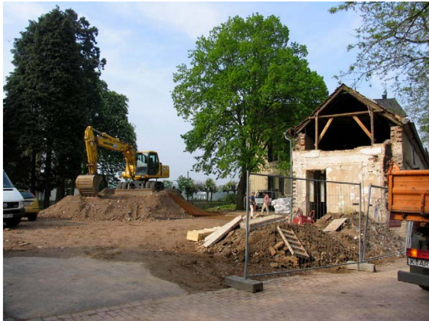
Abbildung 4 Abbruch und Sanierungsmaßnahmen am Hotel Immenhof
