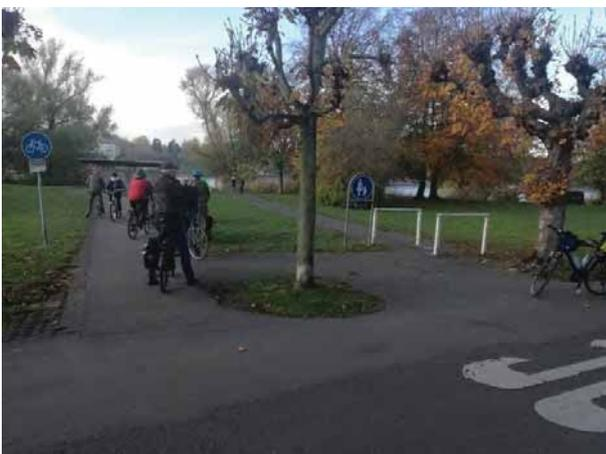
Foto 19: Auch bei der zweiten Kurve (im Hintergrund) sollte im Zuge der Verbreiterung und Sanierung des Radwegs der Radius vergrößert werden.
