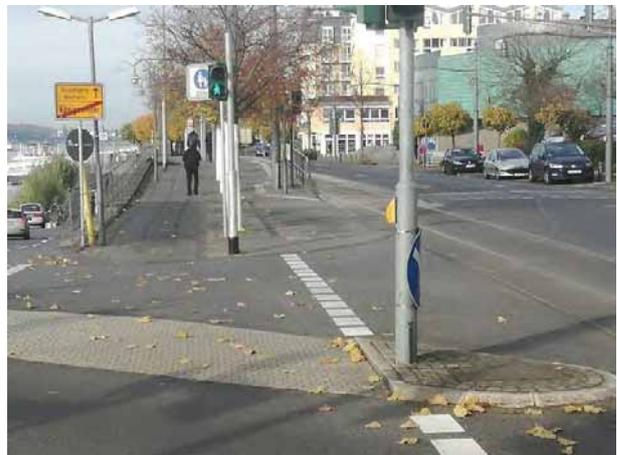
Foto 32: Vor der Fährzufahrt wird der Radverkehr in Südrichtung auf den Bordstein zurückgeführt. Der Radverkehr in links neben dem Bahnsteig auf die Kragfläche geführt.
