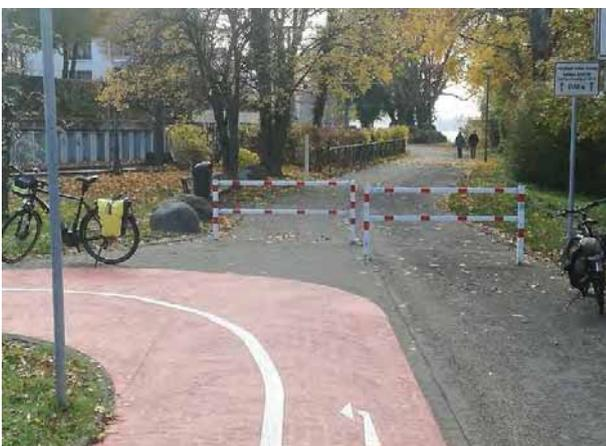
Foto 23: Am Knotenpunkt zur Umfahrroute (6) muss die Geradeausfahrt gestattet und das Drängelgitter entfernt werden; weitere Verbesserung der Sichtbeziehungen.
